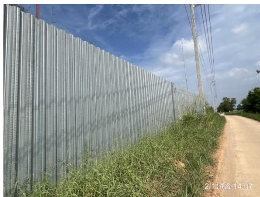
รูปที่ 3.2-13 กำแพงกันเสียงชั่วคราวบริเวณบ้านหลังโรงไฟฟ้า (ด้านทิศใต้ของโครงการ)
