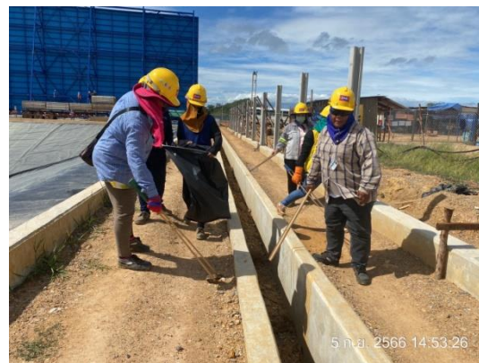
รูปที่ 3.2-21 การตรวจสอบและทำความสะอาด รางระบายน้ำ
