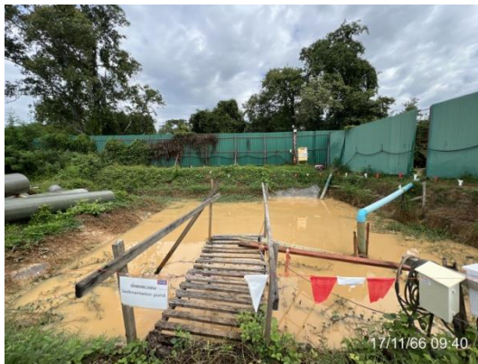
รูปที่ 3.2-28 บ่อตกตะกอนน้ำชั่วคราว ภายในพื้นที่โครงการ
