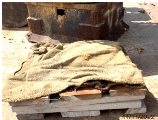
รูปที่ 3.2-14 ไม้หมอนและกระสอบรองหัวเสาเข็ม
